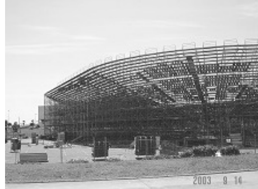
スタンドは鉄のパイプで組み立てているので 応援で揺れる。
