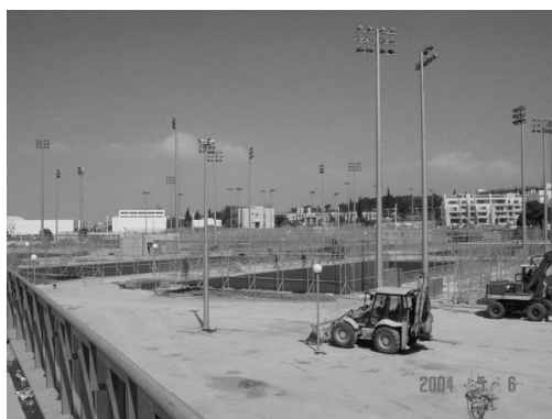
工事中のテニスセンター
