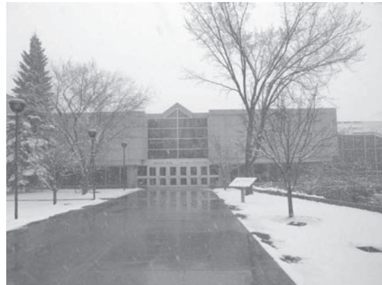
写真1 NTCの正面玄関（カルガリー大学内）
