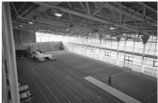
写真2 室内陸上競技場
